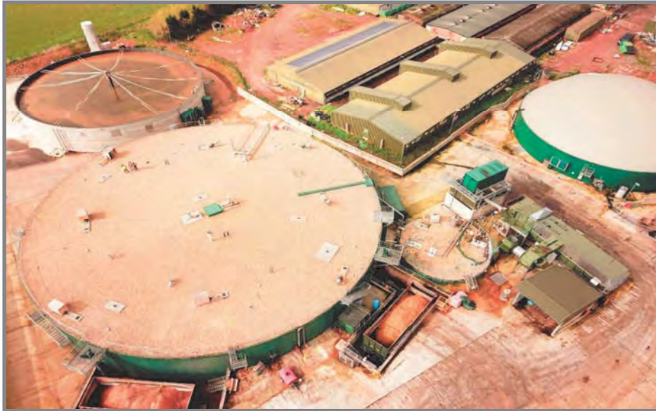
Enfield (UK) 520Nm 3 /h CH 4 , 2016
